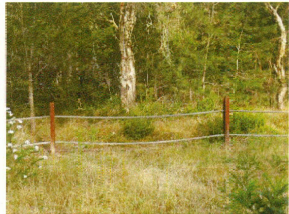
(D) 40mm High tensile dual cable ($95/m)
