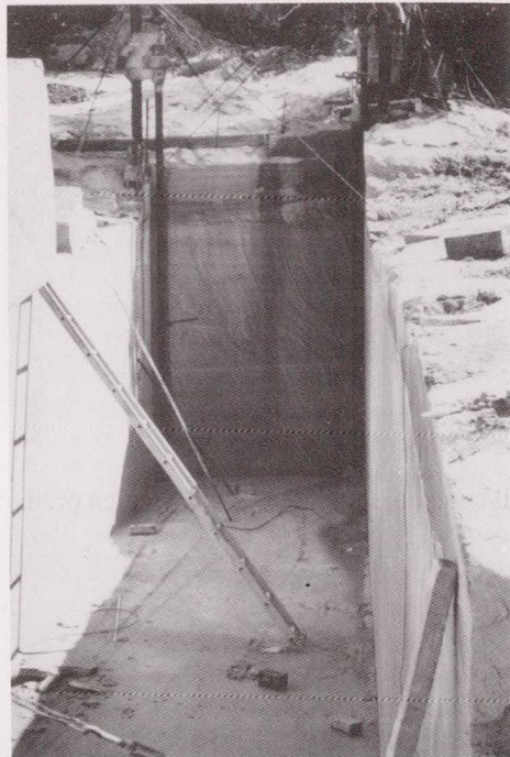
Wire saw, Melocco Pty Ltd
